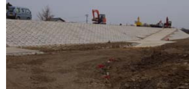
杭瀬川護岸工事風景
